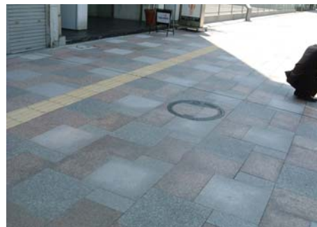
歩道御影石封孔の事例
